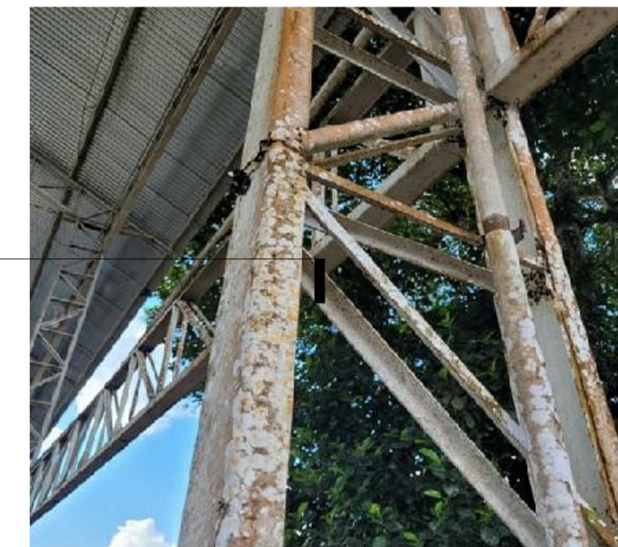
PILARES TRELICADOS A SEREM REVITALIZADOS COM SUBSTITUIÇÃO DE PERFIS
