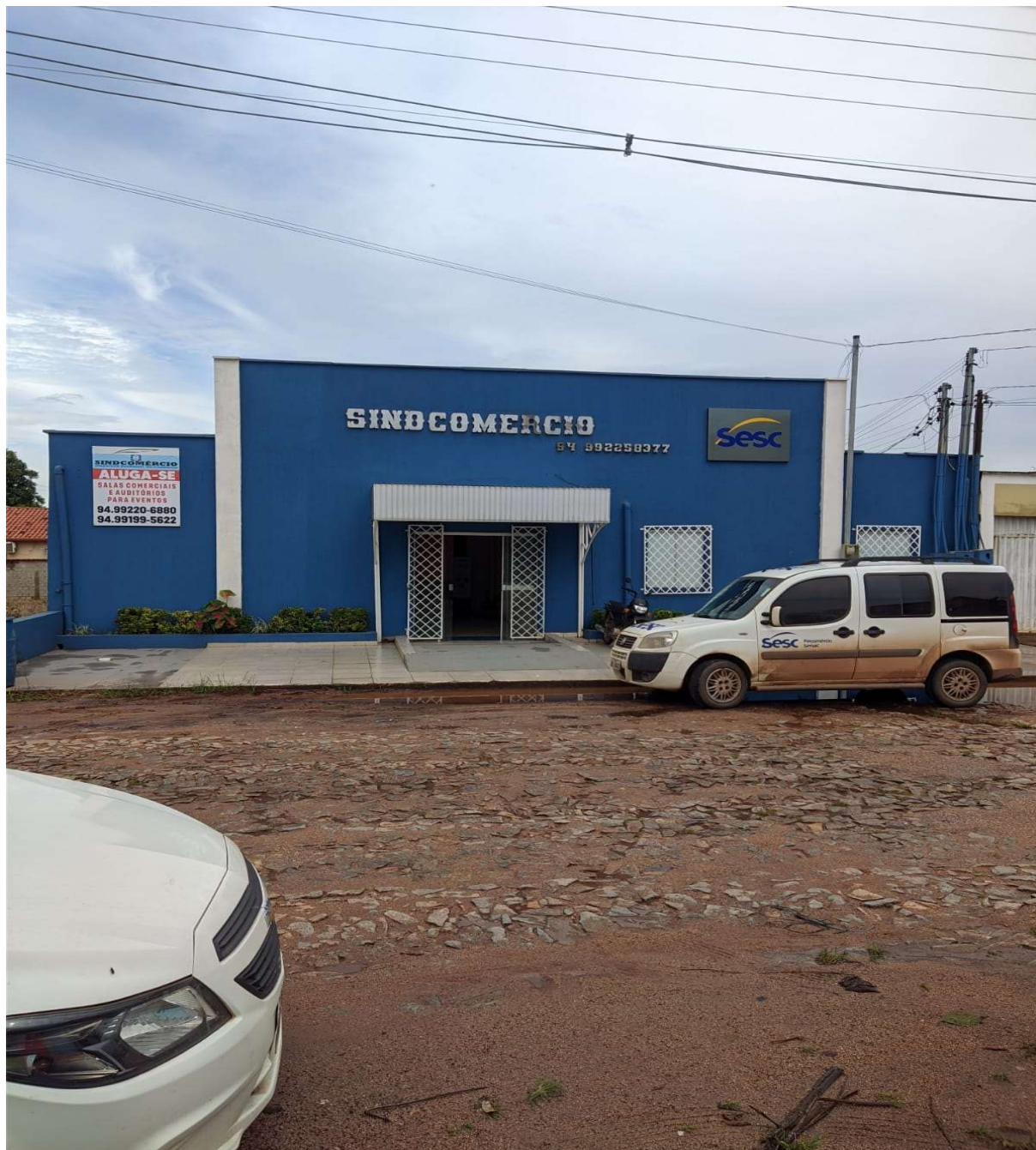
Imagem 04. Fachada antiga SINDCOMERCIO, Redenção/PA.
